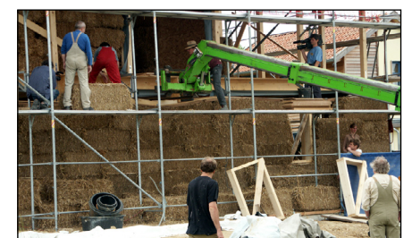
Abb.4 Einsatz eines Frontladers
