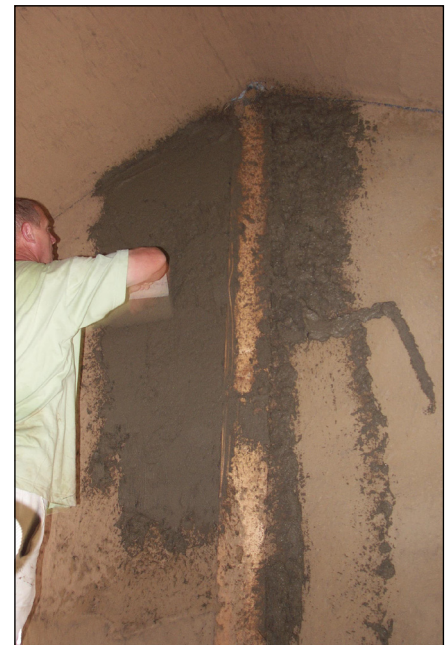
Abb.10 Aufbringen des Strohlehmputzes
