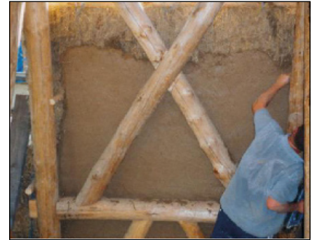
Abb.6 Beim Putzauftrag (ohne Maschine), BV Club 99, Sieben Linden
