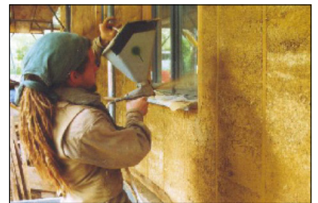
Abb.7 Vorspritzen mit Lehmschlämme
