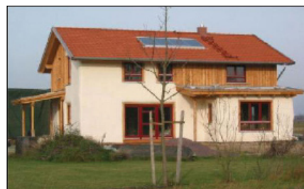
Abb.5 Fertig mit Kalk verputztes Strohballen-Haus (BV Bösel)
