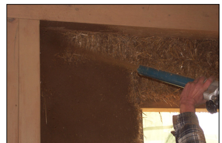
Abb.11 Lehmgrundputz mit maschineller Einblastechnik
