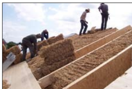
Abbildung 10 Strohballeneinbau/Dach
