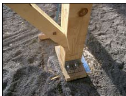
Abbildung 6 Strebenanschluss
