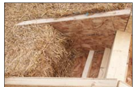
Abb. 11 SB zwischen Kastenträgern
