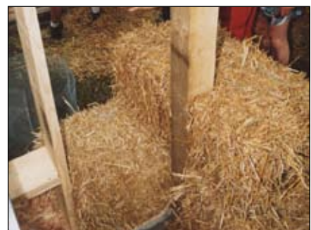
Abbildung 9 Strohballeneinbau
